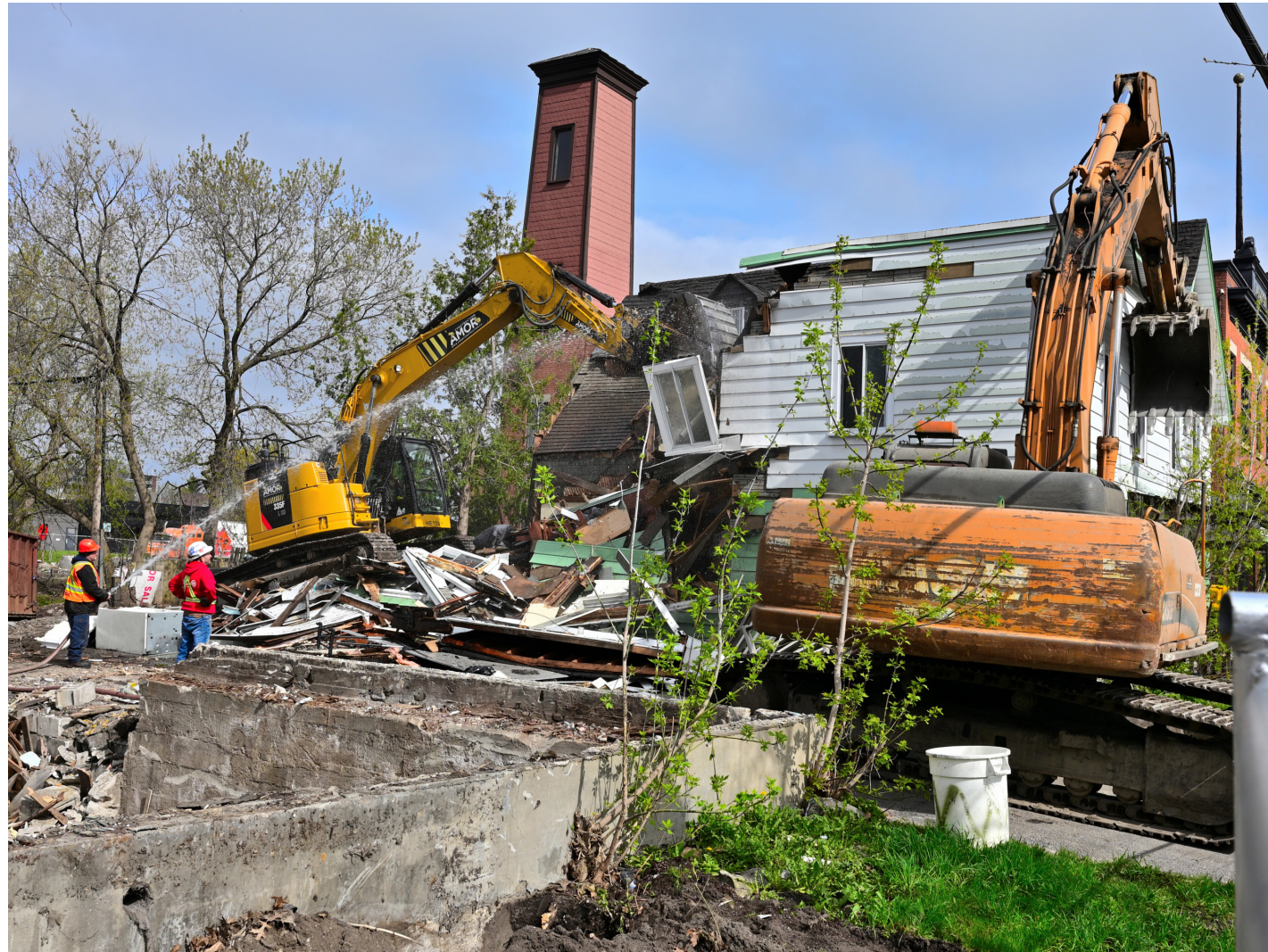
Travailleurs lors de la démolition du 237 rue Champlain
