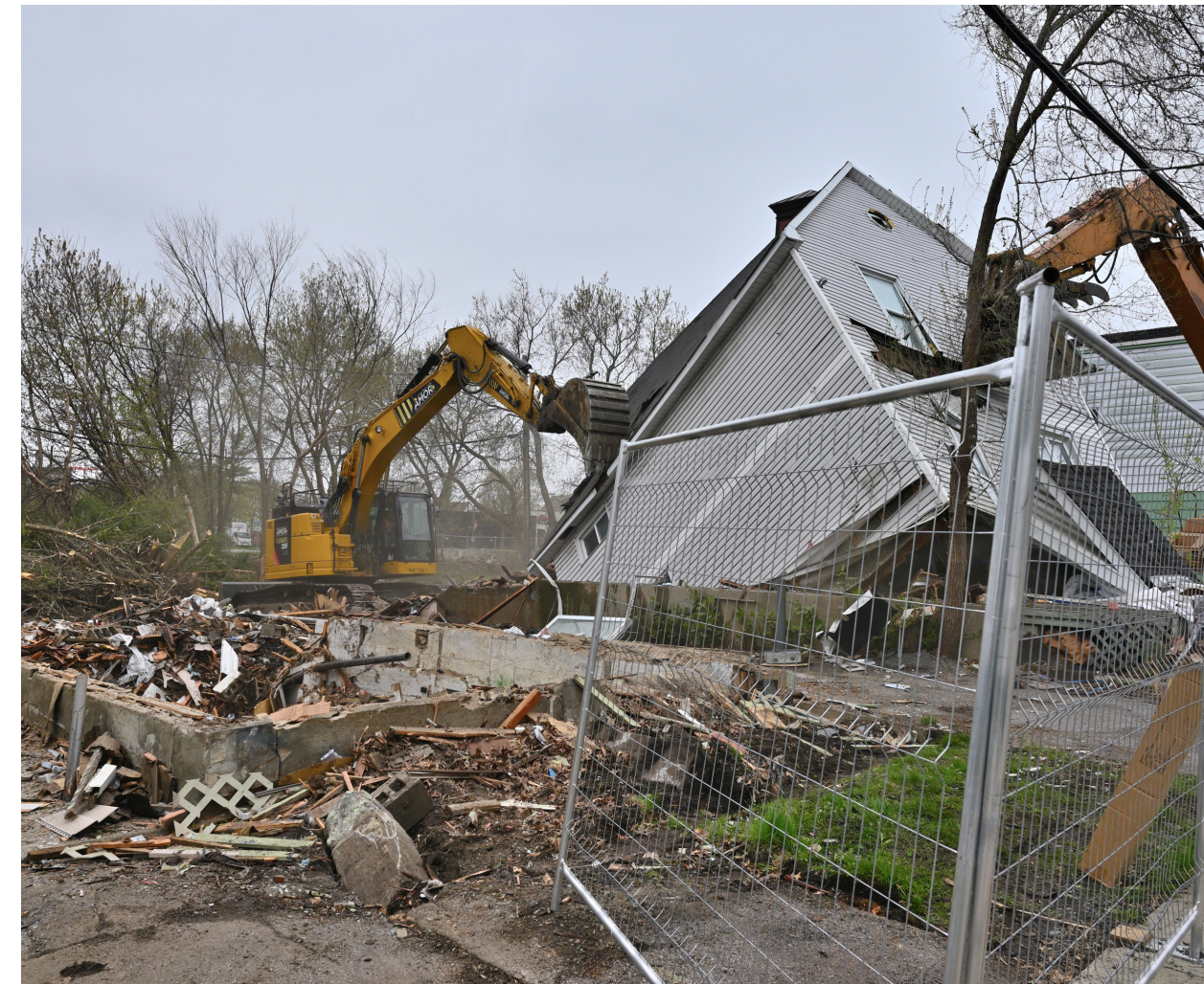
Démolition du 233 rue Champlain
