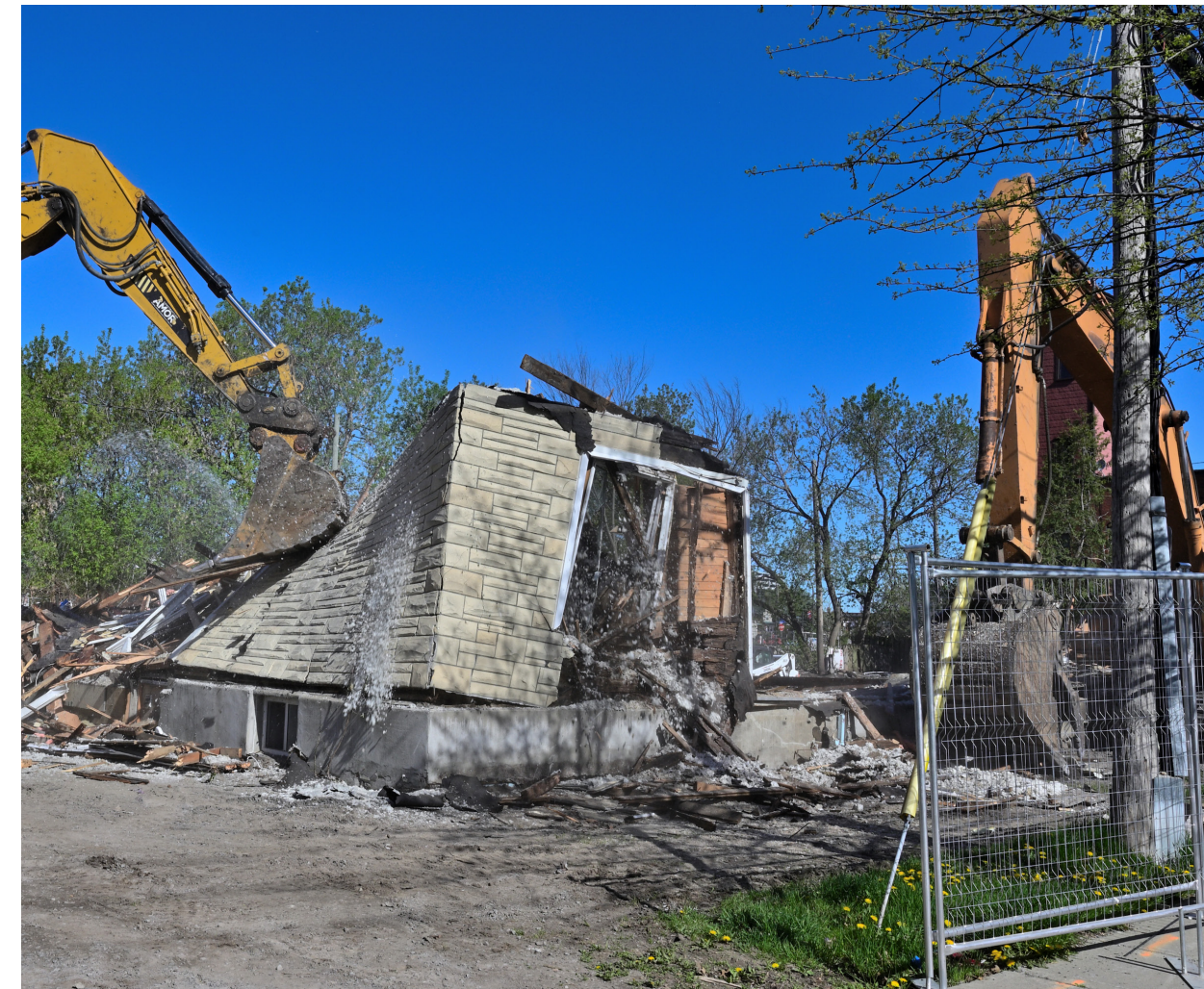
Démolition du 223 rue Champlain
