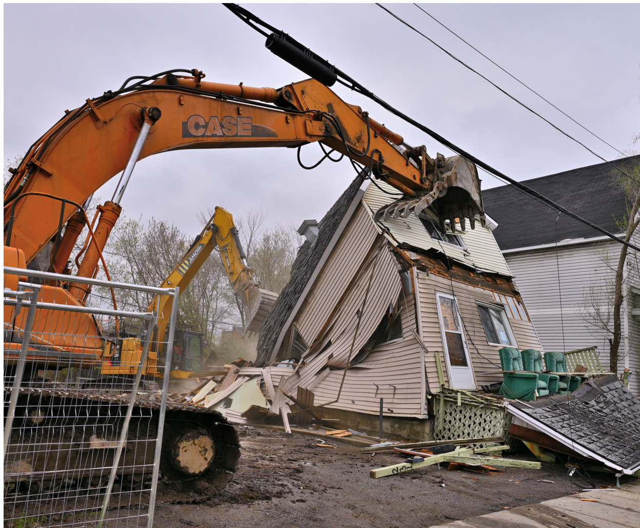
Démolition du 231 rue Champlain
