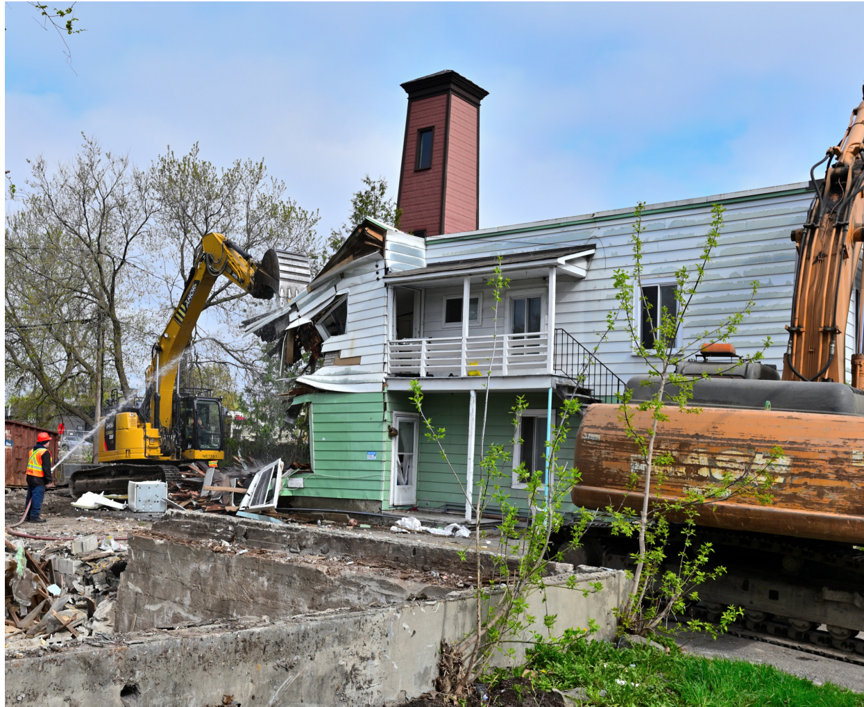
Démolition du 237 rue Champlain
