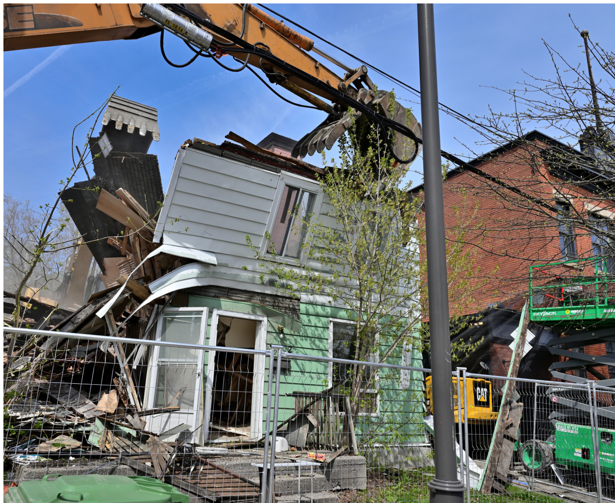
Démolition du 237 rue Champlain
