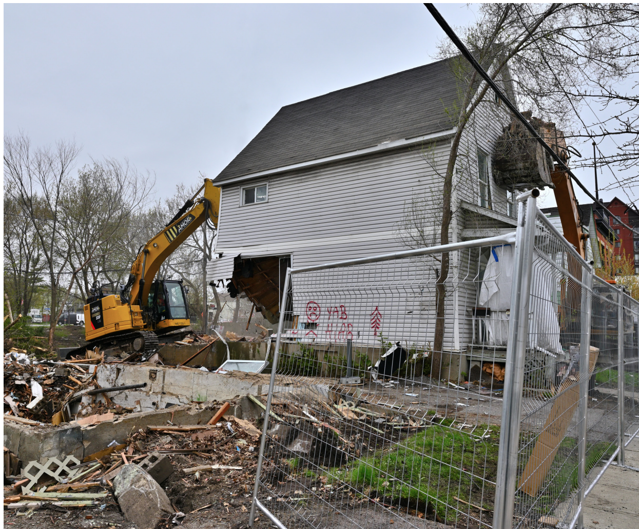
Démolition du 233 rue Champlain
