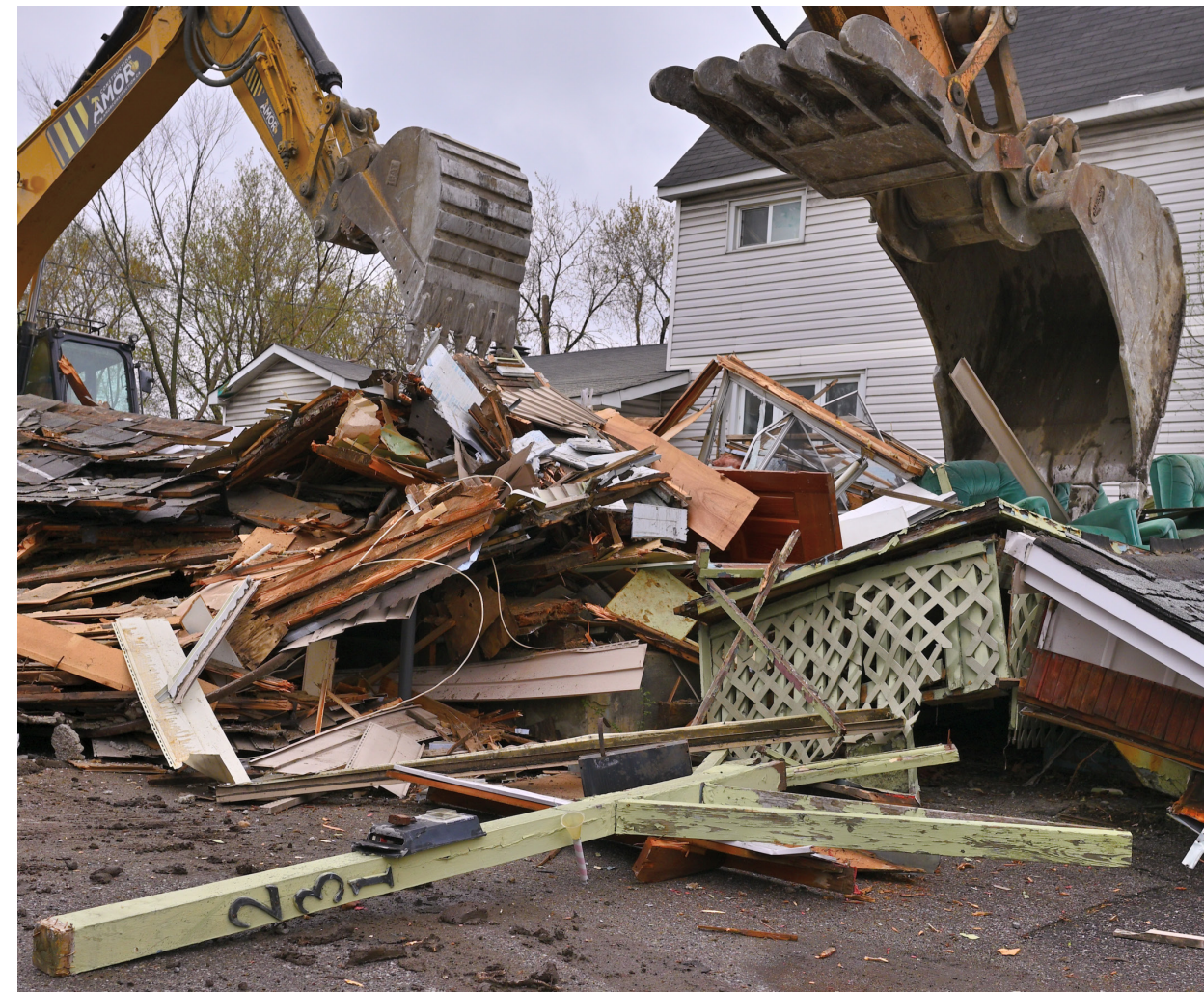
Démolition du 231 rue Champlain
