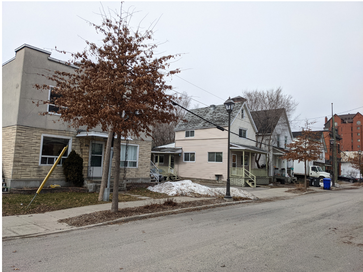
Les maisons autour de la caserne avant leur démolition
