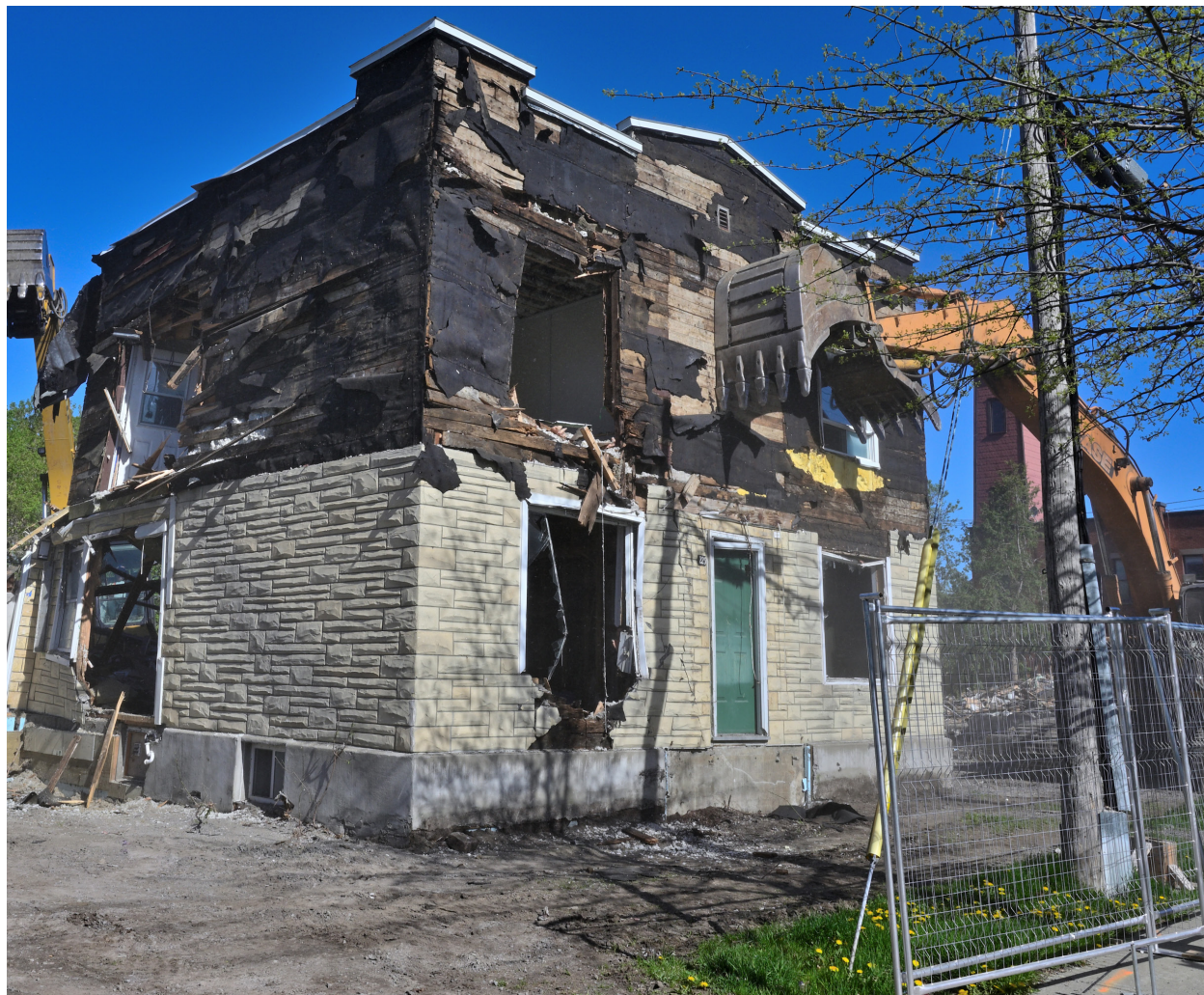
Démolition du 223 rue Champlain
